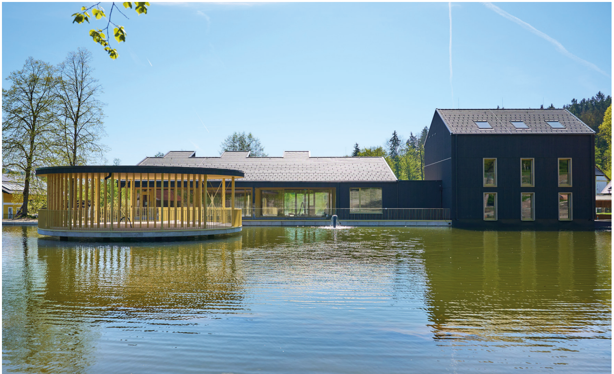
Gesamtanlage des Klimahauses
